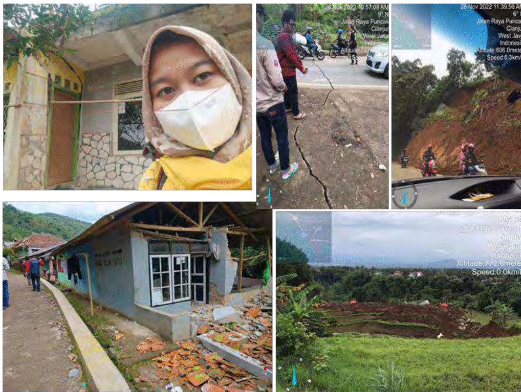
Gambar 3 Dokumentasi kerusakan gempa Cianjur (dokumentasi penulis, 2022)
