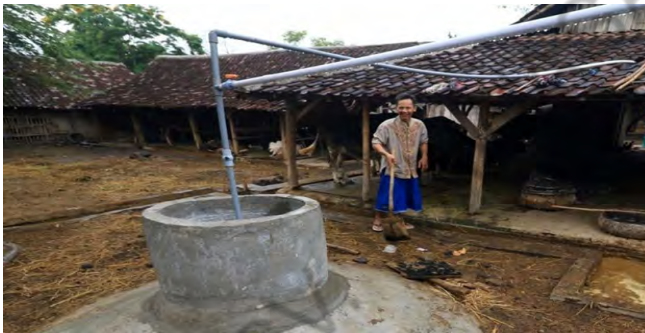
Gambar 27. Bioreaktor penghasil biogas berbahan dasar kotoran sapi (Arifin, 2017)
