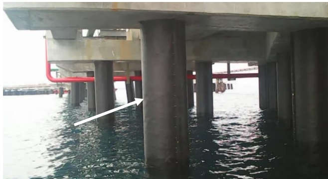
Gambar 4.10 Lapisan ( wrap ) HDPE pada tiang pancang. [ https://www.perintis-proteksi.com/Products/HDPE-JACKET-WRAPPING.html ]
