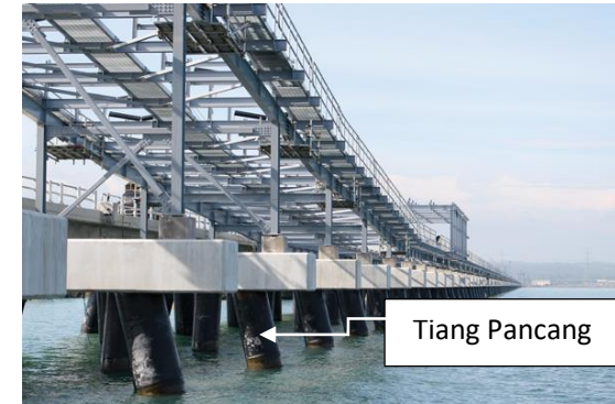
Gambar 4.9. Ilustrasi dermaga dengan tiang pancang baja. [Rico, 2023]
