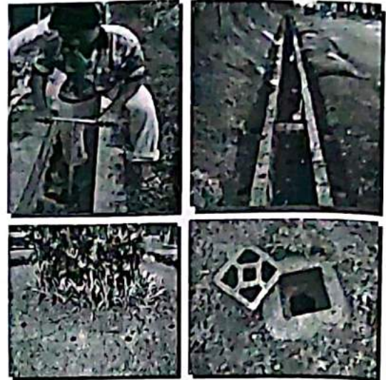
Gambar 11. Pembuatan Lubang Resapan Biopori dan penerapannya di taman maupun di area sekitar saluran. (Sumber: Iwan Ismaun)
