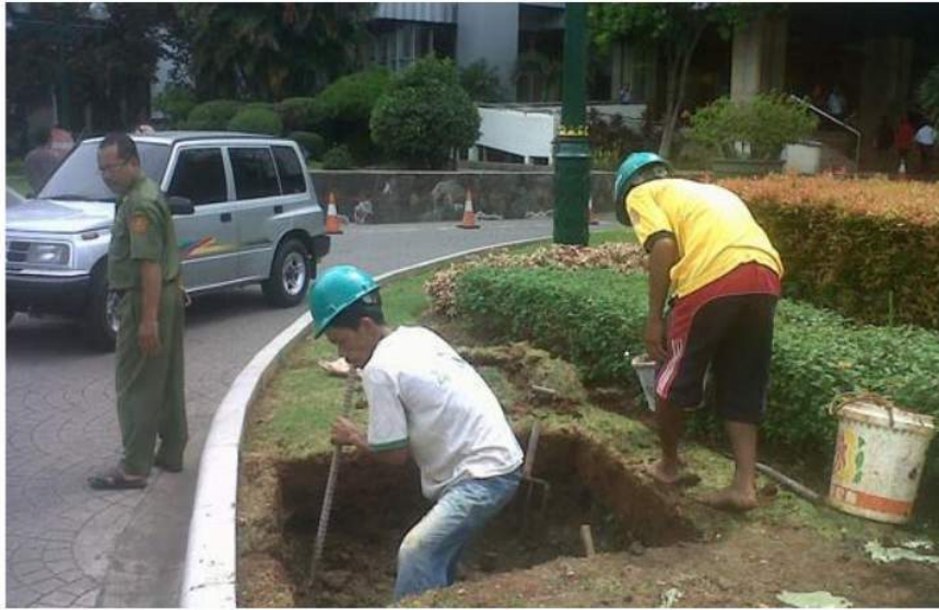
Gambar 8. Pekerja sedang membuat sumur serapan di halaman Balai Kota. (Sumber: TRIBUNNEWS.COM/IMANUEL NICOLAS MANAFE).
