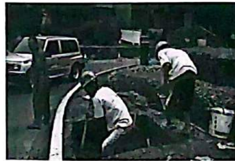
Gambar 8. Pekerja sedang membuat sumur serapan di halaman Balai Kota. (Sumber: TRIBUNNEWS.COM/MANUEL NICOLAS MANAFE )
