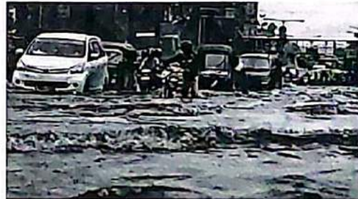
Gambar 3. Genangan bahkan banjir akibat luapan aliran air permukaan. (Sumber: www.aviva.co.id)
