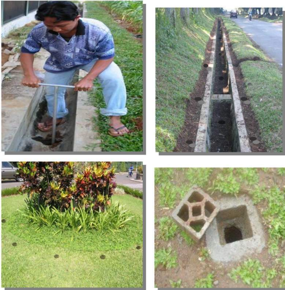
Gambar 11. Pembuatan Lubang Resapan Biopori dan penerapannya di taman maupun di area sekitar saluran. (Sumber: Iwan Ismaun)
