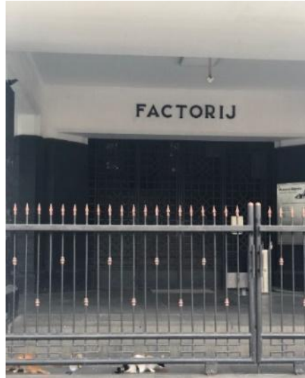
Gambar 15. Pintu main entrance luar Museum Bank Mandiri Sumber : Dokumen Pribadi, 2023
