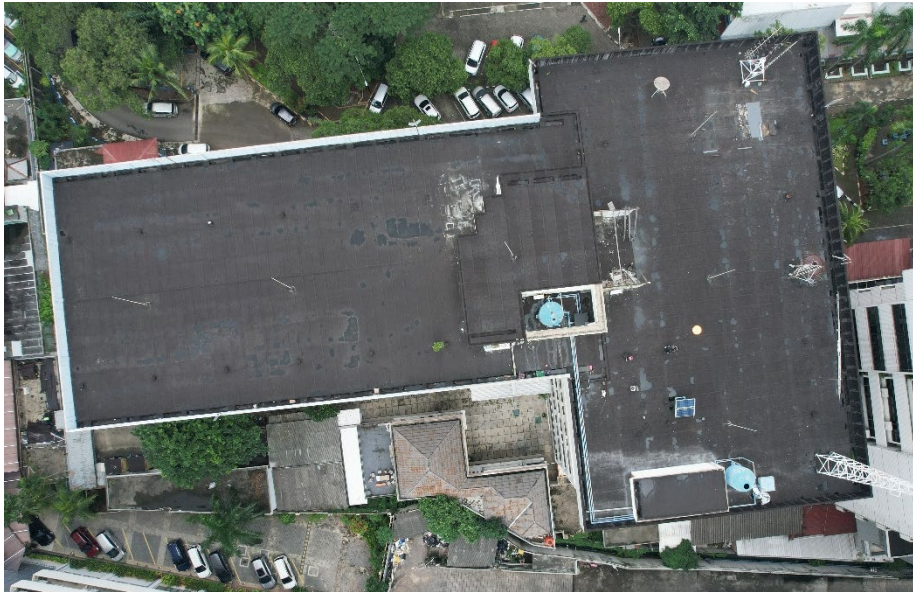
Gambar 4: Citra udara rooftop gedung sebagai objek analisis sistem proteksi petir
