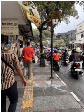
Gambar 4. Kondisi Jalur Pejalan Kaki Eksisting
