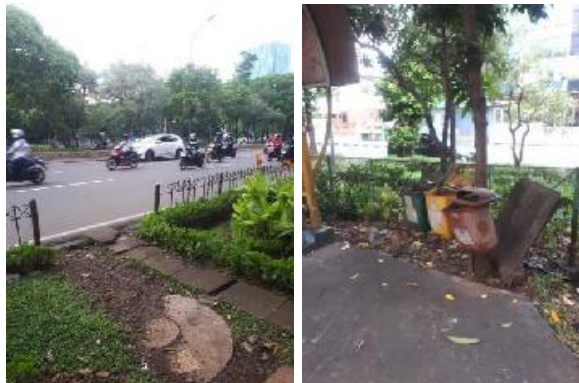
Gambar 7 Kerusakan Elemen Pelengkap Jalur Pejalan Kaki (Dokumentasi Pribadi 2022)
