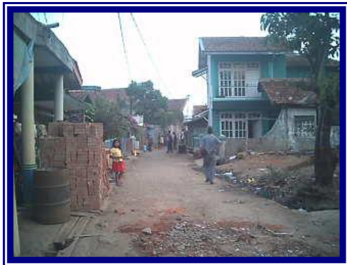
Foto 2-5 Kondisi sebagian jalan desa yang sudah tampak tidak beraspal (tadinya beraspal)
