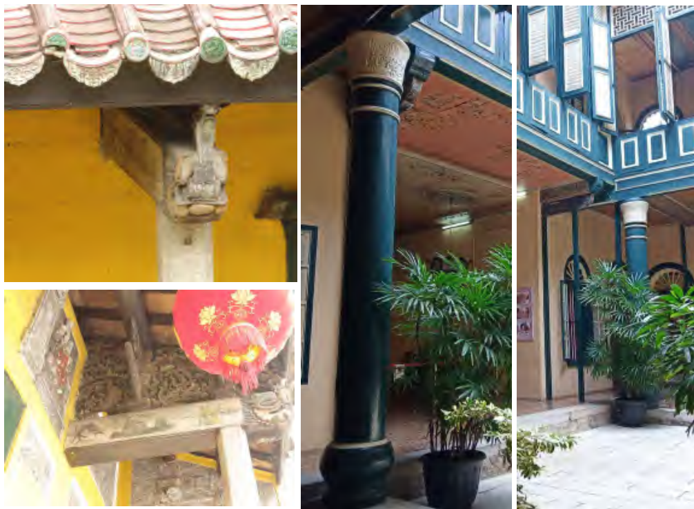
Gambar 4.7 Kolom Penopang Lantai dan Atap Rumah Tjong A Fie Sumber: Dokumentasi lapangan penulis 2019
