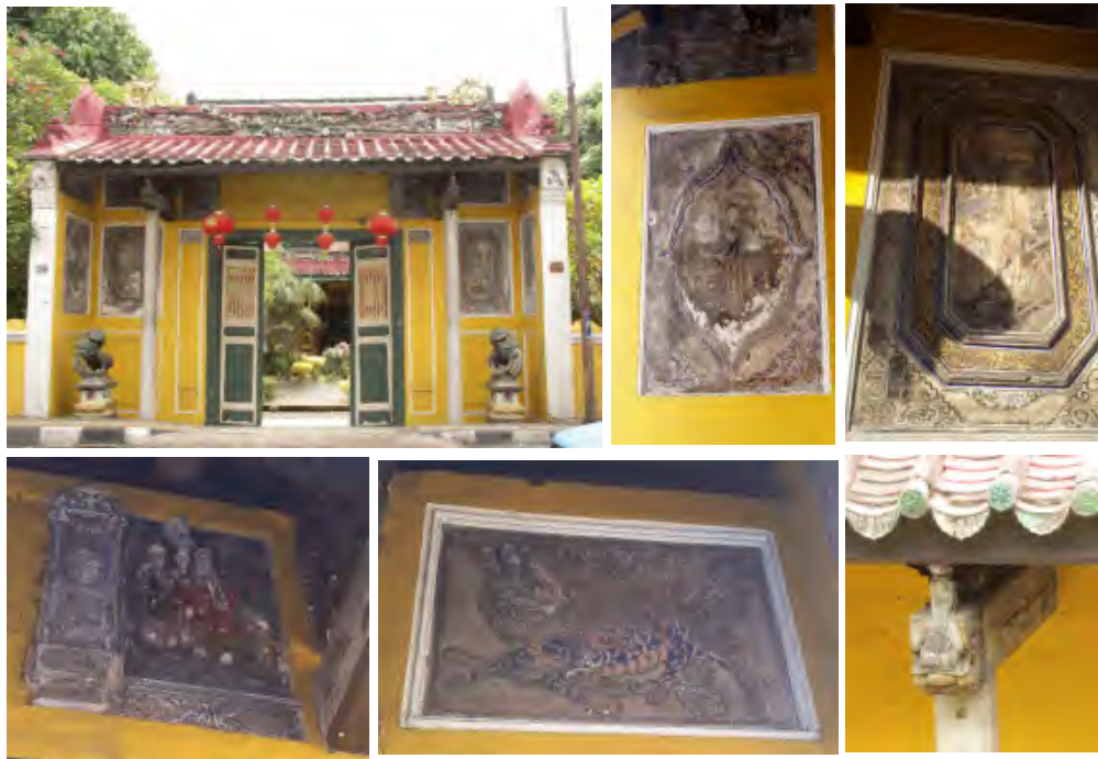
Gambar 4.47 Pintu Gerbang Kondisi Sekarang Rumah Tjong A Fie Sumber : Penulis 2019
