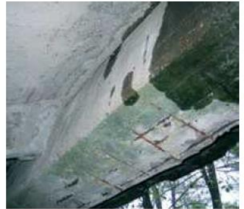
Figure I.1. Photos présentant le cas d'une carbonatation atmosphérique [39]
