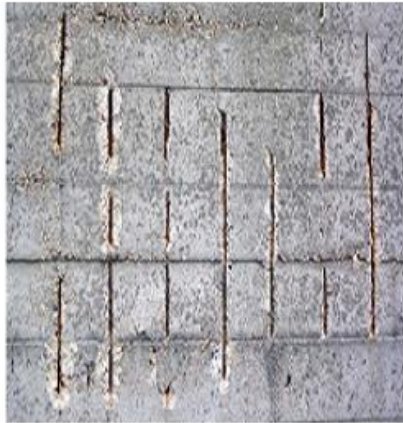
Figure I.1. Photos présentant le cas d'une carbonatation atmosphérique [39]
