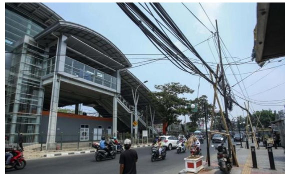
Kesemrawutan trotoar di Jalan Raya M Hasibuan, depan Stasiun Bekasi (kondisi 30/10/2023 pukul 12.38)
