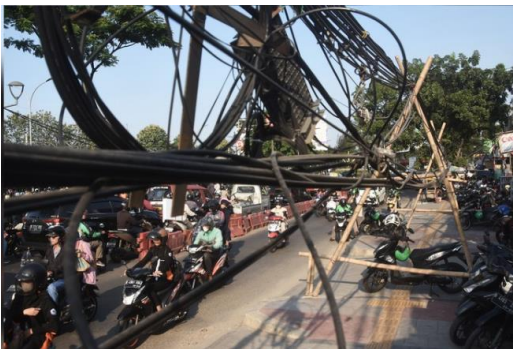
Kesemrawutan ruang udara oleh jaringan kabel (Kasus di Jl. Ir. H Juanda, Bekasi)
