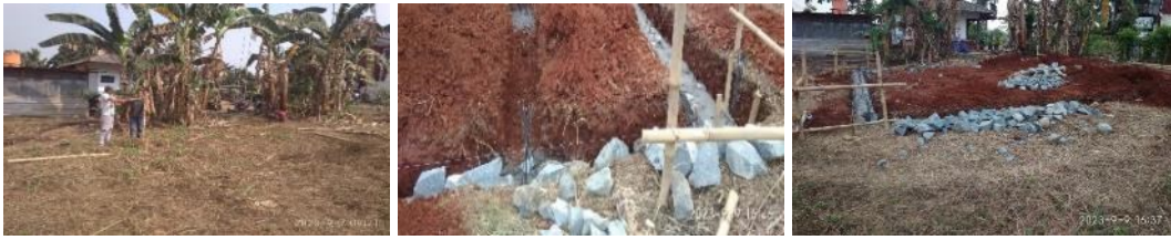
Persiapan dan pekerjaan pondasi
