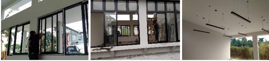
Pekerjaan Kusen dan Lampu
