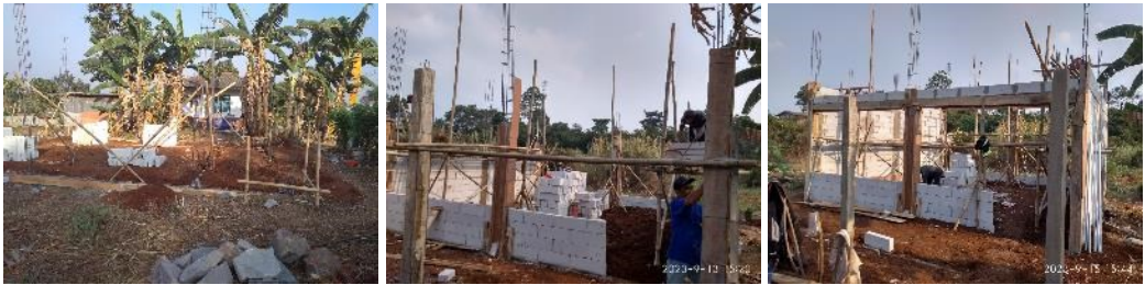
Pekerjaan beton, sloof dan dinding
