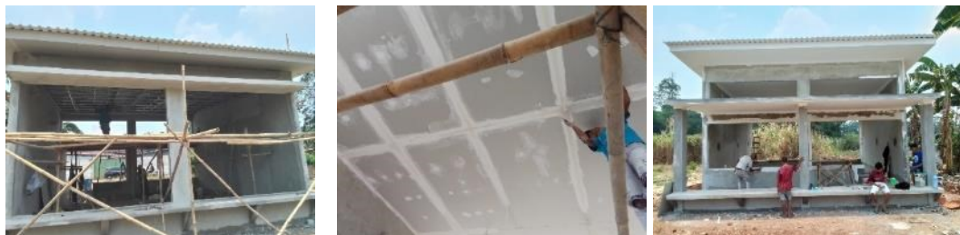
Pekerjaan Plafond dan pengecatan
