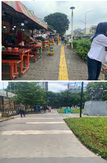
Gambar 6. Kondisi Jalur Pedestrian
