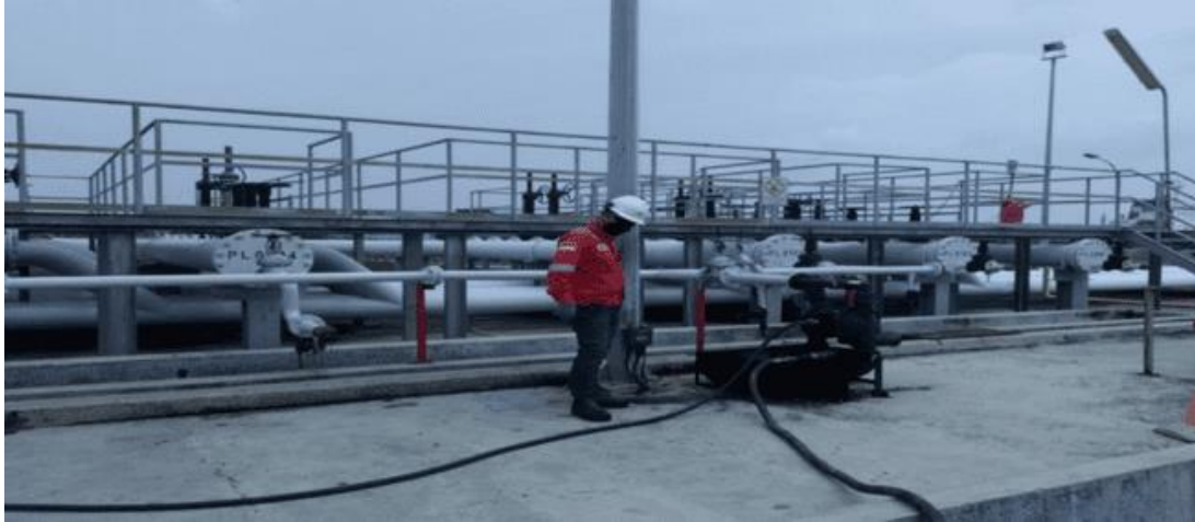
Gambar 3.2 Pekerja melakukan Proses Inject Dyes menggunakan compressor, hose
