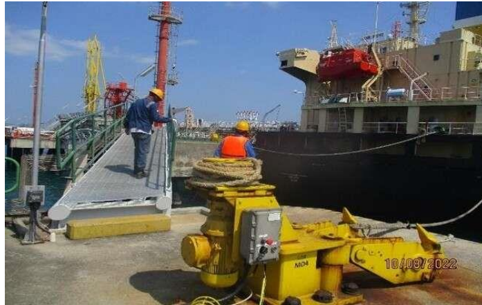
Gambar 1.4 Fasilitas Fisik Jetty
