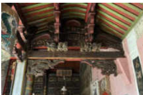
Konstruksi atap bangunan penghubung
