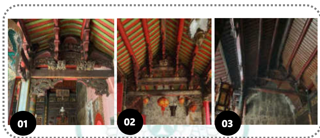
Gambar 57. Gambar 01, kuda-kuda atap teras, Gambar 02, kuda-kuda atap ruang duduk/serba guna, Gambar 03, kuda-kuda atap ruang altar utama
