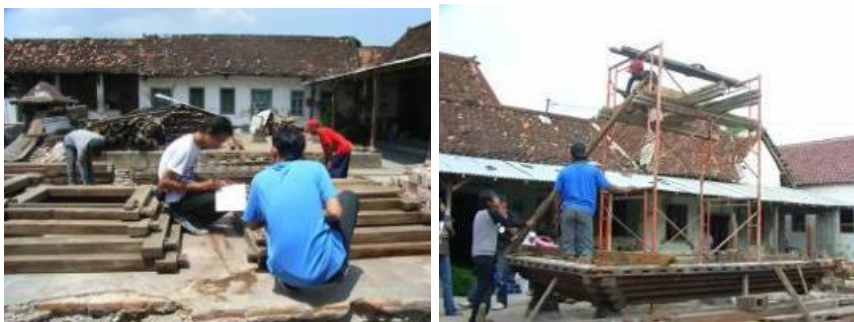
Gambar 10.13. Pengukuran detail untuk rumah Edy Priyanto di Desa Jagalan. Pada saat pengukuran bangunan yang roboh, perlu pula diperkirakan posisi komponen bangunan yang satu dengan yang lainnya
