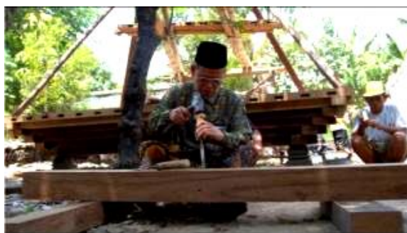
Gambar 10.14. Pekerjaan simbolis dalam rekonstruksi rumah tradisional masih dilakukan. Pada pengerjaan komponen yang dianggap khas, biasanya didahului doa-doa yang diangkat oleh tokoh agama
