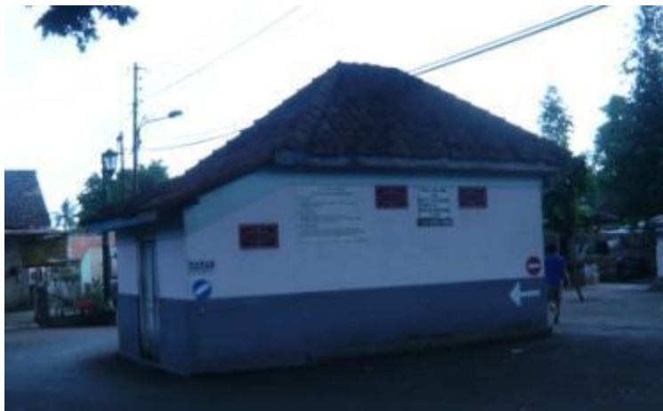
Gambar 10.4. Batu Watu Gilang, yang diyakini sebagai singgasana Panembahan Senopati, bersama Watu Gentong dan Watu Gatheng disimpan dalam bangunan tertutup berbentuk cungkup . Bangunan cungkup Watu Gilang dibangun pada tahun 1980-an.
