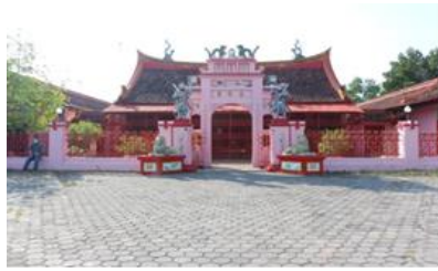
Tampak depan kompleks bangunan
