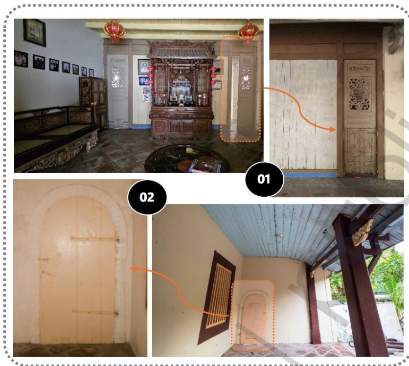
Gambar 88. Gambar 01, Pintu kayu diruang altar menuju teras belakang, Gambar 02, pintu samping rumah belakang
