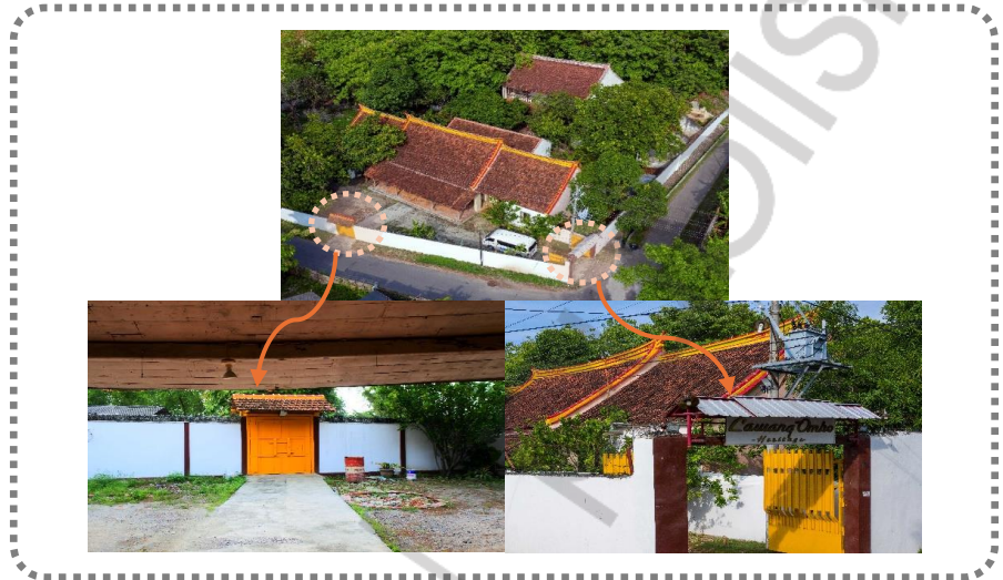
Gambar 92. Lokasi dan kondisi gerbang
