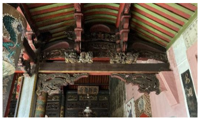
Konstruksi atap bangunan penghubung
