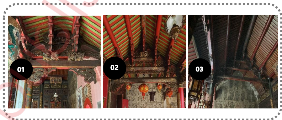
Gambar 56. Gambar 01, kuda-kuda atap teras, Gambar 02, kuda-kuda atap ruang duduk/serba guna, Gambar 03, kuda-kuda atap ruang altar utama
