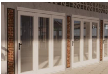
Gambar 19. Penggunaan Folding Window & Roster sebagai Penghawaan Alami
