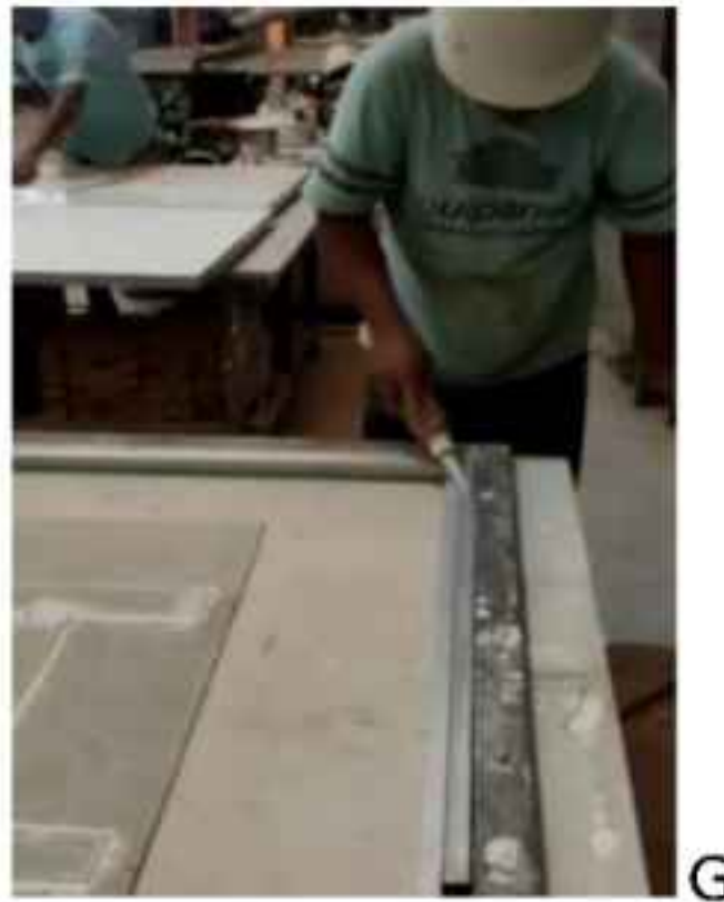
Gambar 8. Proses pemasangan metal furing pada kalsiboard
