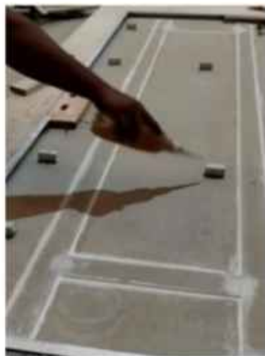
Gambar 9. Pemasangan potongan kecil metal puring
