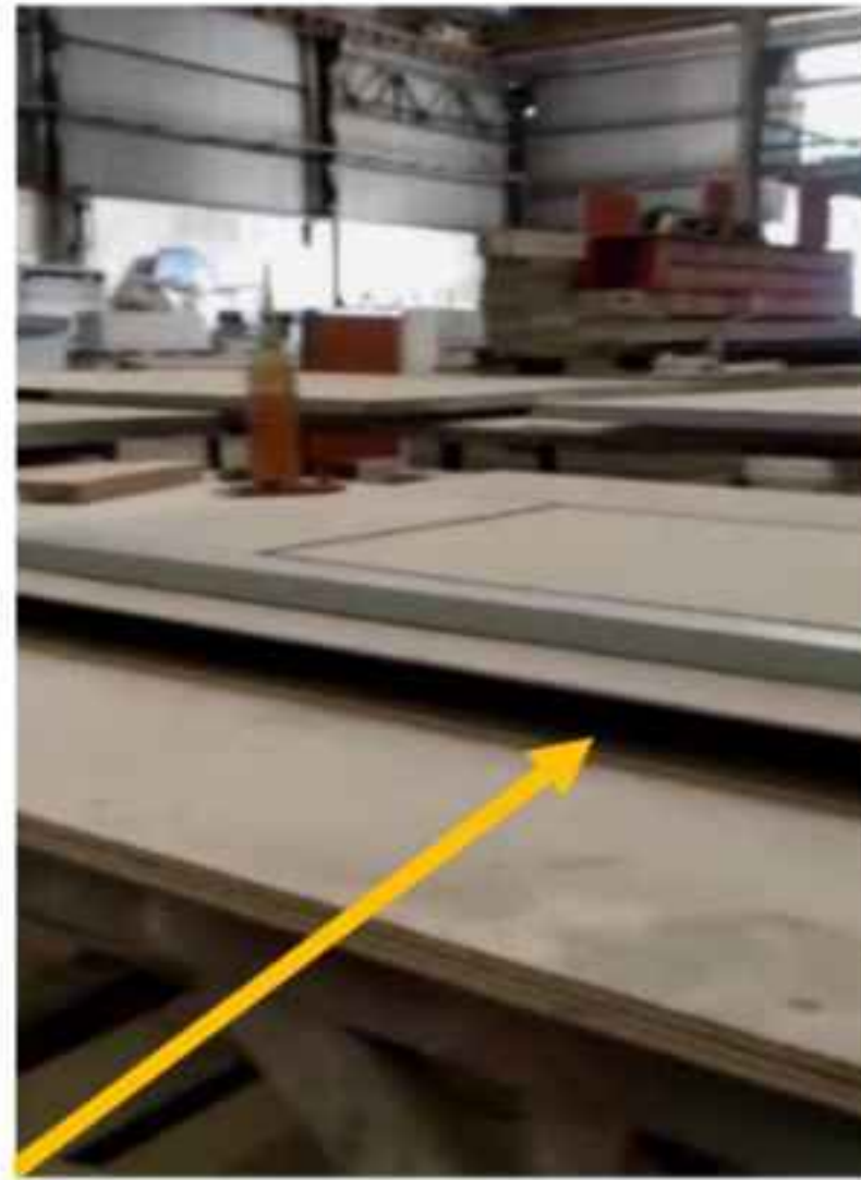
Gambar 11. Lubang daun pintu untuk memasukkan beton
