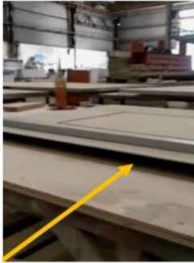
Gambar 11. Lubang daun pintu untuk memasukan beton
