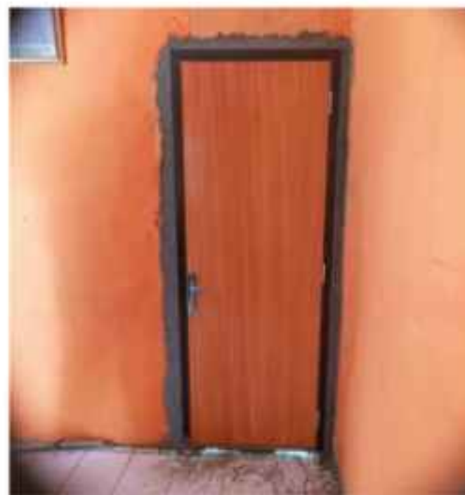
Gambar 14. Daun Pintu Berbahan beton ringan terpasang
