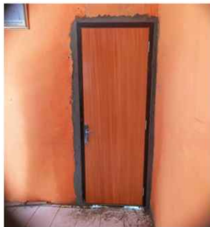
Gambar 14. Daun Pintu Berbahan beton ringan terpasang
