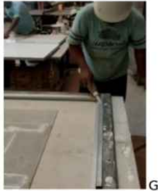
Gambar 8. Proses pemasangan metal furing pada kalsiboard
