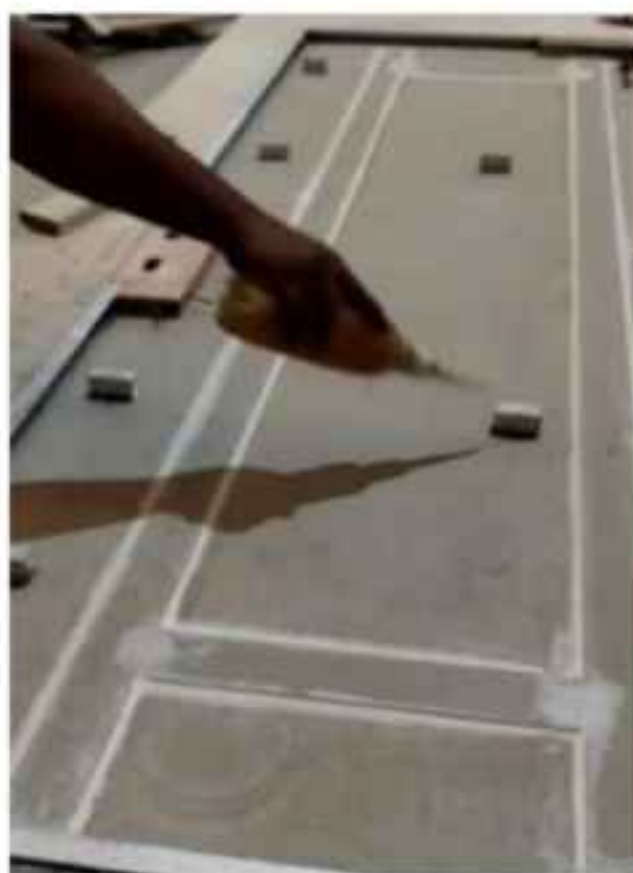
Gambar 9. Pemasangan potongan kecil metal puring
