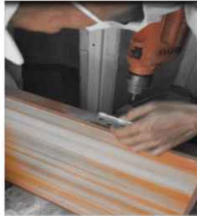
Gambar 13. Proses memasang engsel pada daun pintu panel beton ringan
