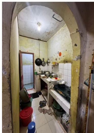
Gambar 9. Tampak dapur dan toilet
