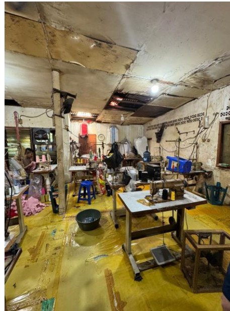
Gambar 13. Sisi kanan lantai 2
